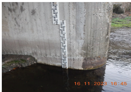
Фиг. 4. Определяне на наклоните на водната повърхност с помощта на нивомерни рейки, монтирани в спомагателните створове
